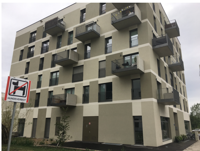
Neu vor den Toren Wiens: der Que(e)rbau.
